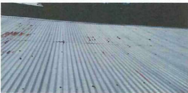
Foto 5: Se identifica que la cubierta de láminas del centro educativo se encuentra en mal estado, lo que provoca filtraciones de agua durante la época de lluvias.
