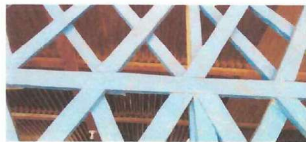
Foto 4: Se observa que las ventanas del centro educativo son provisionales y están fabricadas de madera, lo que puede afectar la seguridad, ventilación e iluminación de los espacios.
