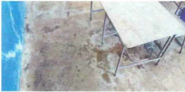
Foto 1: Se puede observar el deterioro de la torta de concreto, evidenciando grietas y un desgaste notorio a la vista.
